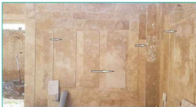
تصویر ۱-۲ شکل کاملاً غیریکنواخت بر روی سنگ نما
