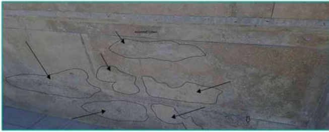
شکل ۳-۲ فرآیند شوره زدن و پودر شدن در برخی از نقاط سطح سنگ نمایان است
