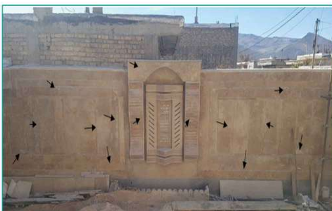
تصویر ۲-۲ فرایند پوسته شدن و پودر شدن در برخی از نقاط سطح سنگ
