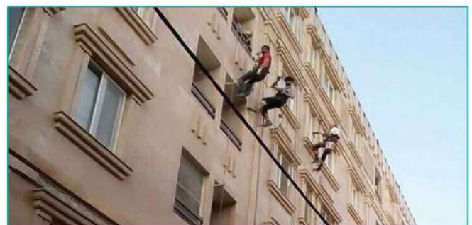
تصویر ۱- پوشش مواد محافظ نانو بر روی سنگ نما
